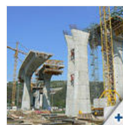
Konstrukce během výstavby
