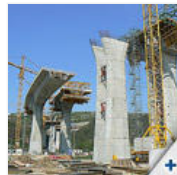
Brücke im Bauzustand
