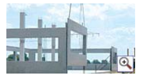
Mammut-Gebäude aus Fertigteilen
