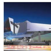
Le cristal est une structure acier entièrement vitrée qui s'appuie en partie sur le socle et en partie sur le nuage. Il est constitué d'une structure secondaire appuyée par l'intermédiaire de potelets de liaison sur une structure métallique primaire. Les liaisons entre le nuage et le cristal autorisent le glissement entre les 2 structures.
