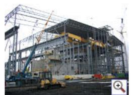
Sämtliche konstruktive Arbeiten wurden in ESA-Prima Win vorgenommen. Die Dachstruktur und die Säulen sowie die Wände wurden als 3D-Modell berechnet, die Längsfüllstäbe als 2D-Modell.
