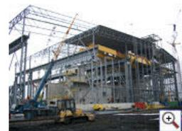
Toute la conception a été réalisée avec ESA-Prima Win. La structure du toit, les poteaux et les voiles sont calculés dans un modèle 3D. Les contreventements longitudinaux sont, quant à eux, calculés dans un modèle 2D.
